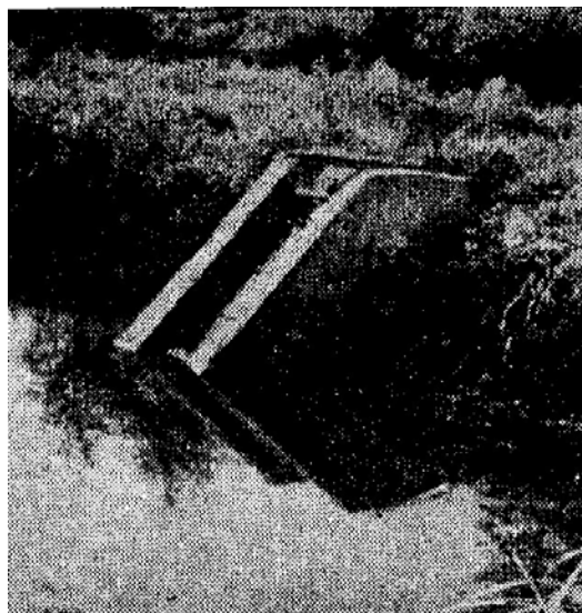
Рис. 49. Наклонный бетонный стояк
